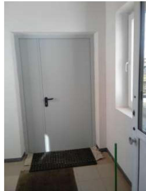
Установлена новая железная противопожарная входная дверь при входе в школу
